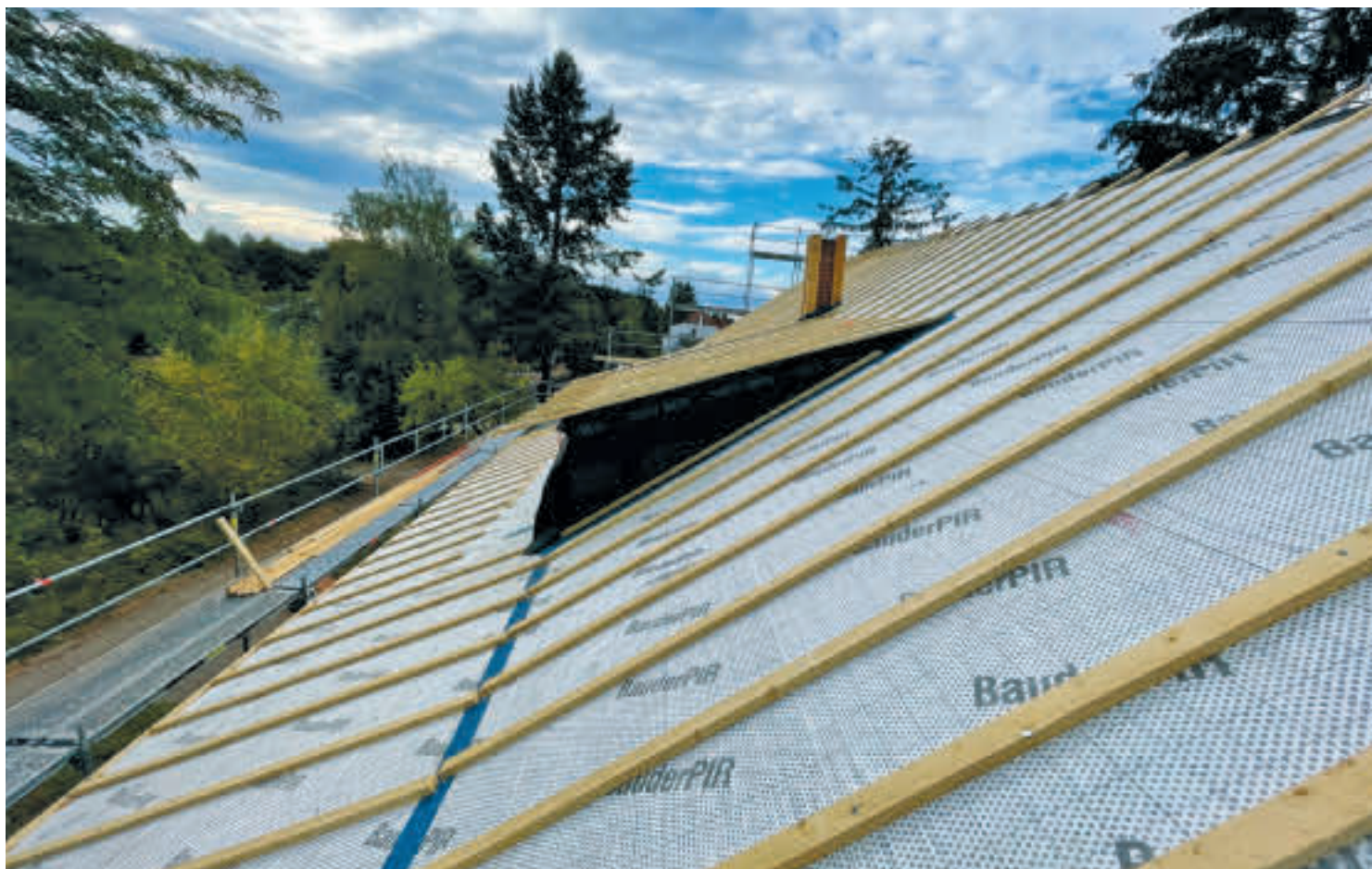
Energetische Dachsanierung / Foto: Sascha Michely
