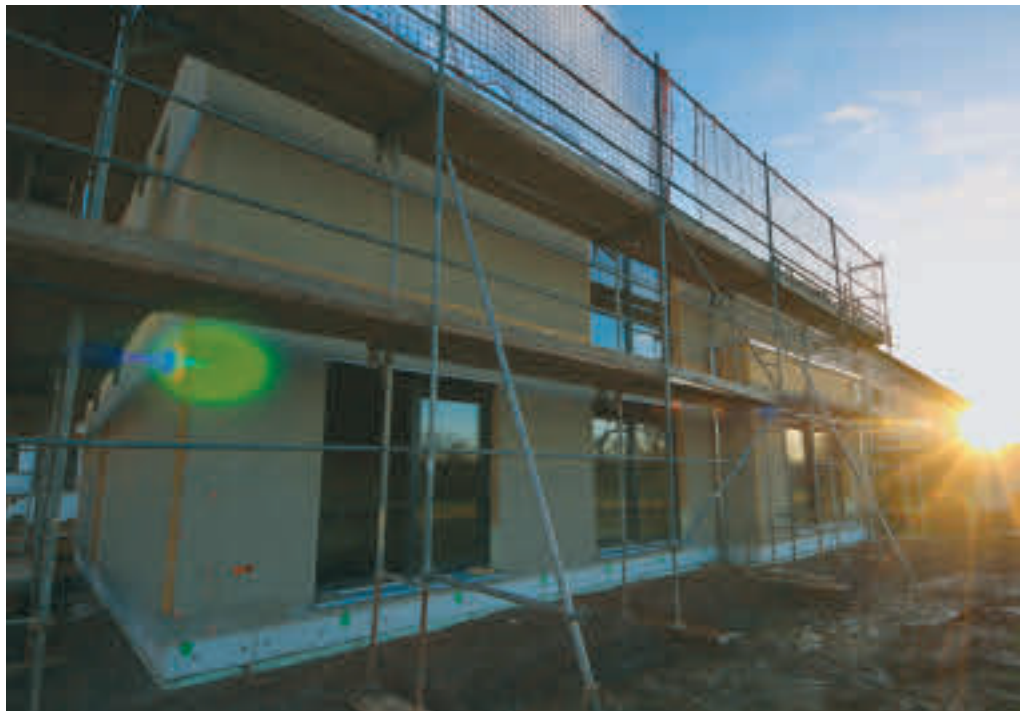
Gerüst am Neubau / Foto: Angelina Müller
